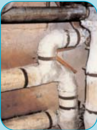
Asbestos pipe lagging
